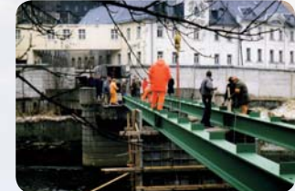
Auf den Resten der 1945 gesprengten Saalebrücke wurde im Dezember 1989 eine Fußgängerbrücke - die „Brücke der Freiheit“ - errichtet. Foto: Bahner, Hirschberg
