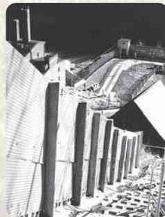
Sperranlagen am Schlossfels Foto: Rolf Rückel, Hirschberg
