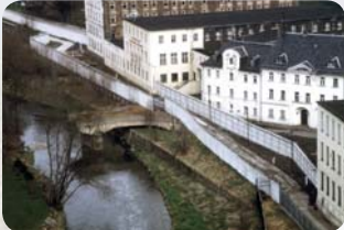
Doppelmauer vor dem „Alten Bürogebäude“ der Lederfabrik. Zwischen 1963 und 1966 wurde die drei Meter hohe Mauer vom Schlossfels bis zum Ende der Uferstraße errichtet. Eine zweite kam 1983 aufgrund steigender Fluchtversuche hinzu. Foto: Mediathek des Deutsch-Deutschen Museums Mühlhausen
